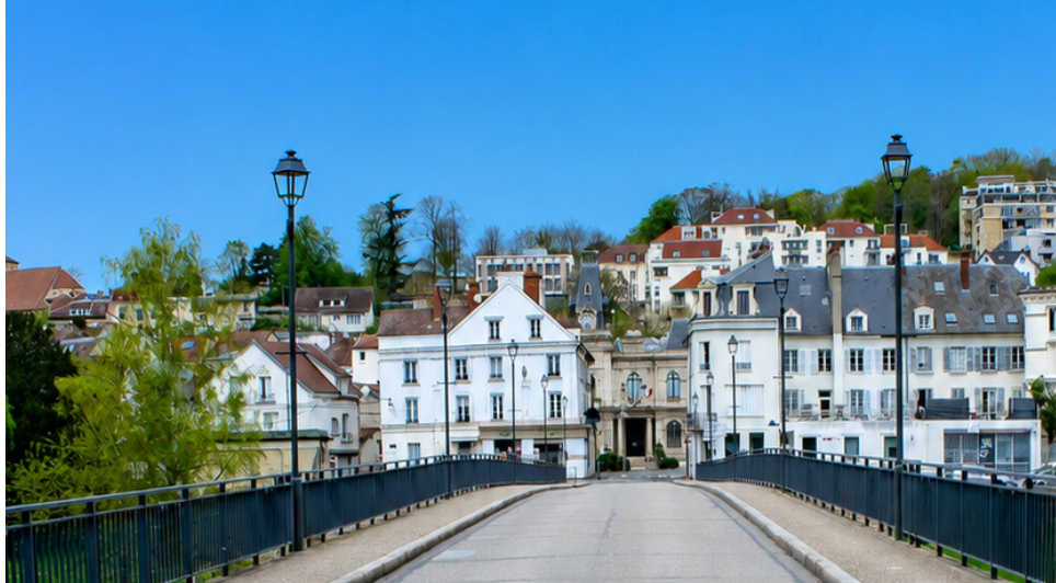
PONT AUX PERCHES ©VILLEDEMEULANENYVELINES
