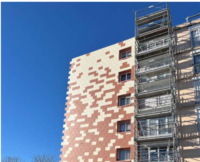
TRAVAUX D'ISOLATION PAR L'EXTERIEUR ©VILLEDEMEULANENYVELINES
