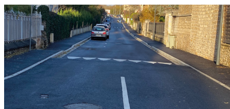
Achèvement de la réfection totale de la rue de Tessancourt
