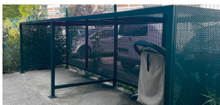
Création d'un local à poussettes à la Maison de la Petite enfance
