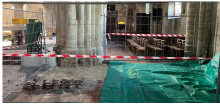
Travaux de réhabilitation de l'église Saint-Nicolas
